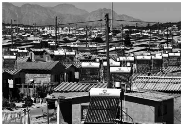
Figure 28: Projet Kuyasa de rénovation énergétique de 2 300 maisons (Photo : Sustainable Energy Africa)
