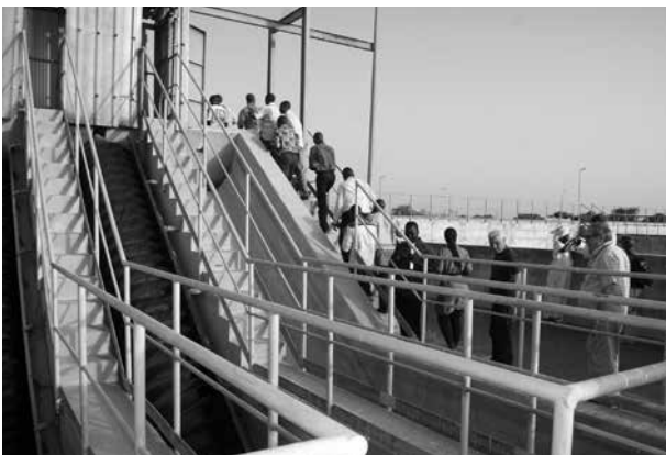
Figure 14 : Visite de la station d’épuration de la ville de Thiès, Sénégal (Photo : Djibril Diop)
